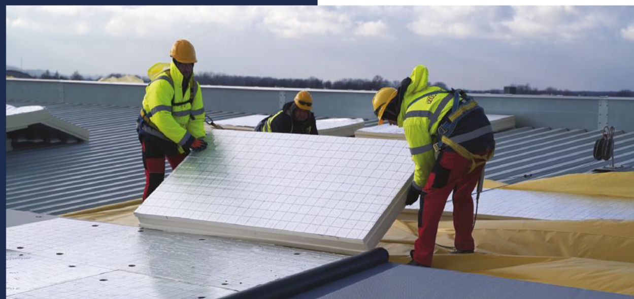
Montáž deskaů termPIR® na rovné střeše
