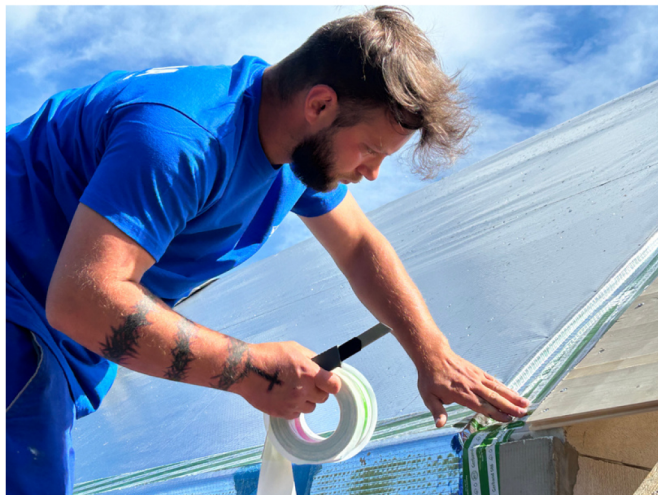
Parotěsné napojení na štitovou zeď.
