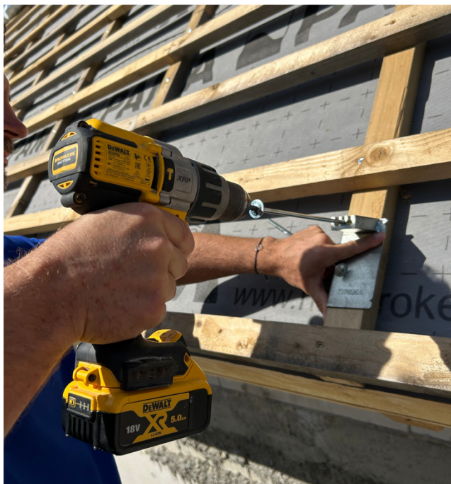
Kotevní vruty prošroubujeme skrz izolaci až do krokve.
