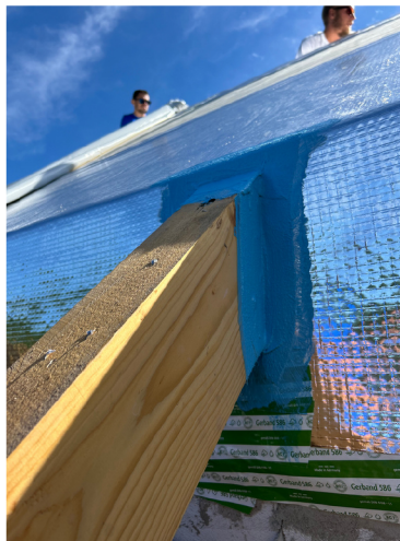
Parotěsné napojení na krov.
